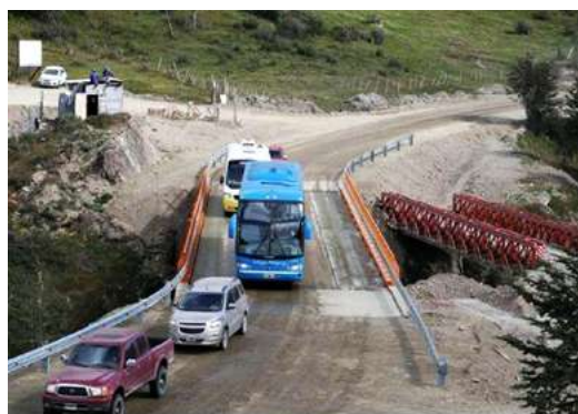
Puente sobre el río Pipo (Ushuahia) hecho en ARS
